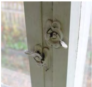
Vanhoja ja mahdollisesti alkuperäisiä ikkunaheloja löytyy rakennuksen länsiosasta (kuvassa vasemmalla). Luokkahuoneissa on uudempia, mahdollisesti 1950-luvulta peräisin olevia ikkunaheloja (kuvassa oikealla).
