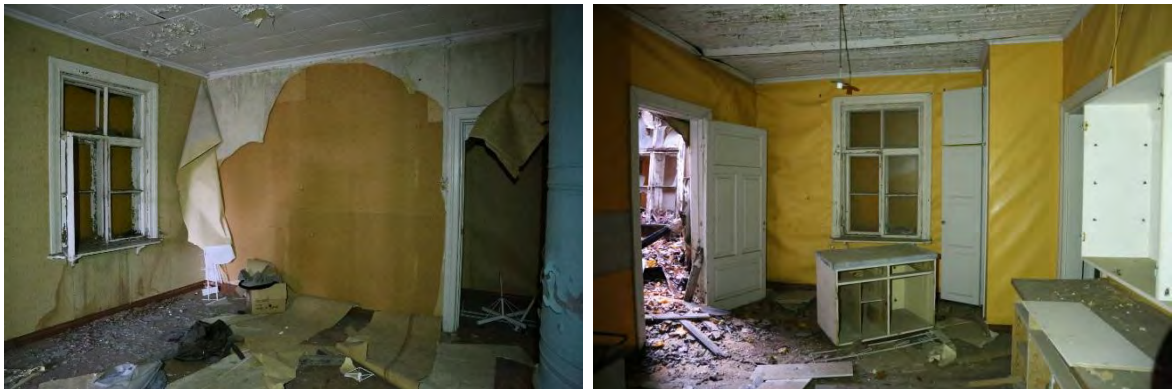
Rakennuksen itäosan puoleisia huonetiloja. Vasemmalla on asuinhuone ja oikealla keittiö.
