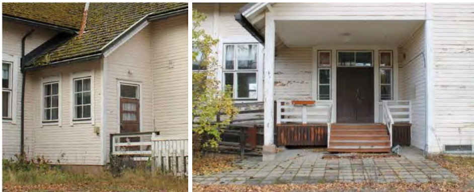
Kuvassa vasemmalla etupihan sisäänkäynti ja oikealla takapihan sisäänkäynti.
