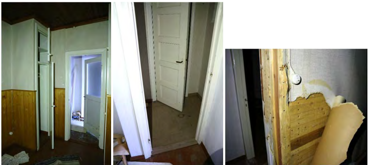
Vasemmalla on tien puoleinen huone. Keskellä on kuvattuna eteisestä pesuhuoneeseen. Oikealla näkyy seinärakennetta.
