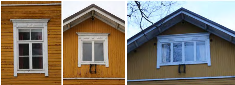
Vasemmalla pääjulkisivujen 6-ruutuinen puuikkuna, keskellä eteläpään ullakkoikkuna ja oikealla pohjoispään ullakkoikkuna.
