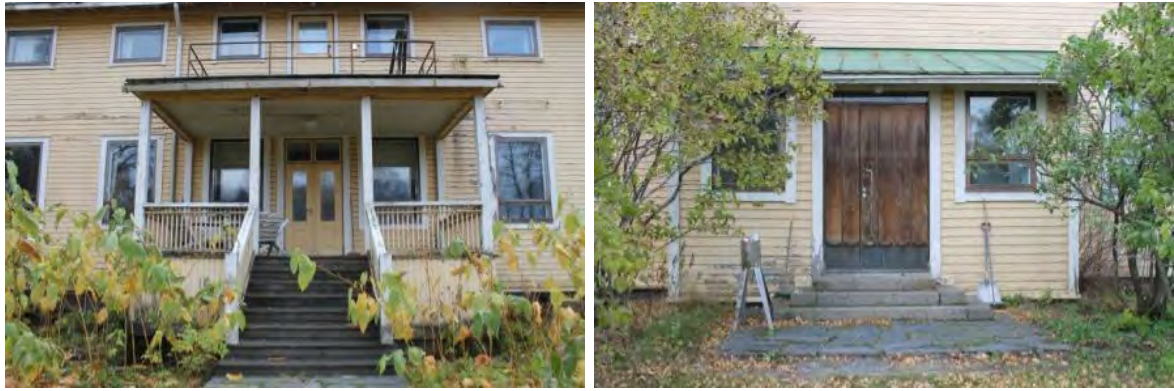
Vasemalla takapihan terassi ja oikealla etupihan pääsisäänkäynti.
