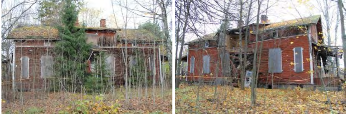
Vasemmalla julkisivu etelään ja oikealla julkisivu pohjoiseen.
