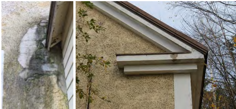
Vasemmalla rappauksen alta paistaa tiilipinta. Oikealla yksityiskohta räystään rappauslistoin muotoillusta, porrastetusta umpiräystästä ja kissanpenkistä.
