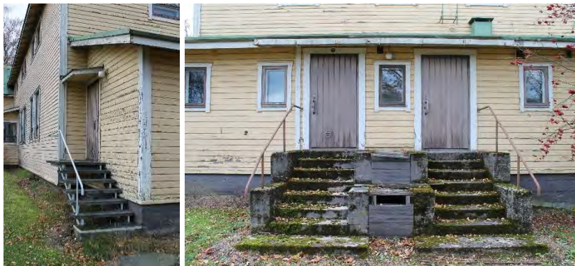
Keittiön sisäänkäynnit ovat rakennuksen itäosassa.
