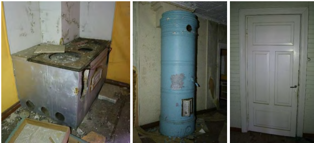
Keittiössä on vanha hella (vasemmalla) ja asuinhuoneessa on vanha siniseksi maalattu pönttöuuni (keskellä). Väliovet ovat vanhoja puuovia. Oikealla asuinhuoneen ja eteisen välinen väliovi.
