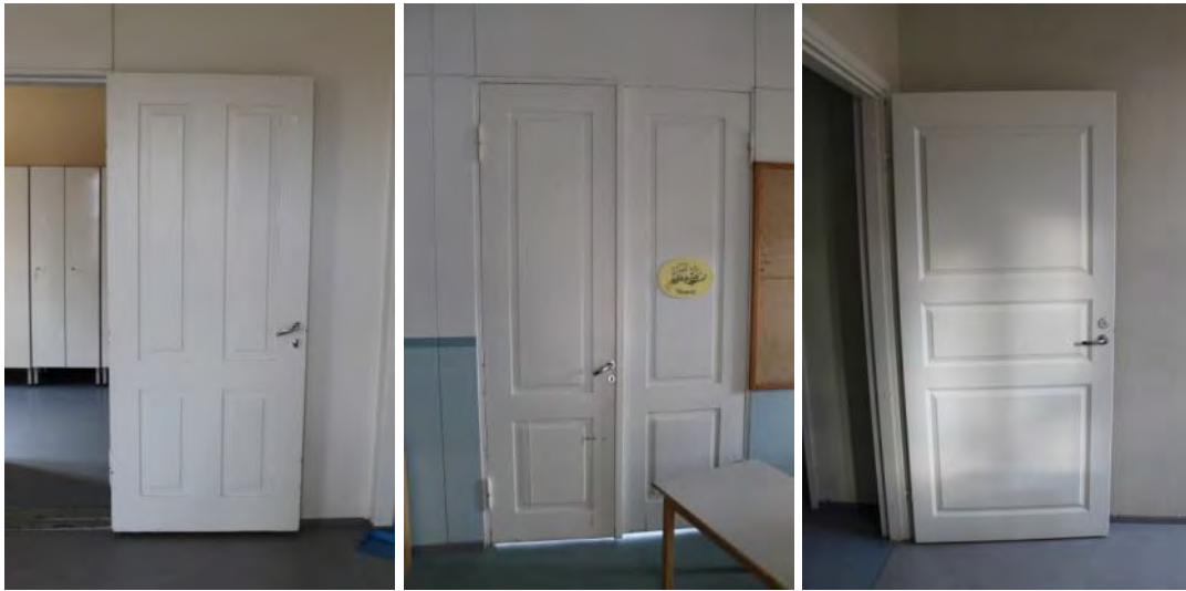
Vanhoja puuovia löytyy muun muassa henkilökunnan työhuoneesta (026) sekä entisistä luokkahuoneista (011 ja 016). Uudemmat ovet ovat ulkoasultaan vanhoja puuovia muistuttavia (kuvassa oikealla johtajan työhuoneen 021 ovi).
