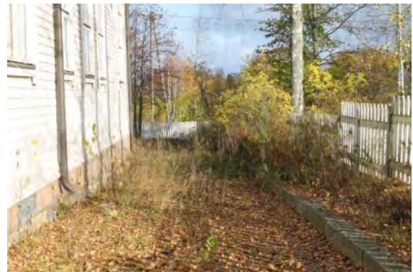
Pihan eteläpuoleisella rajalla on graniittikivillä reunustettu istutusalue.
